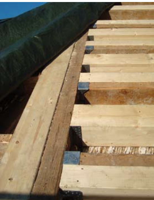
Mit Balkenschuhen und Winkelverbindern erhöhten die Zimmerleute die Gesamtsteifigkeit der Dachkonstruktion.
